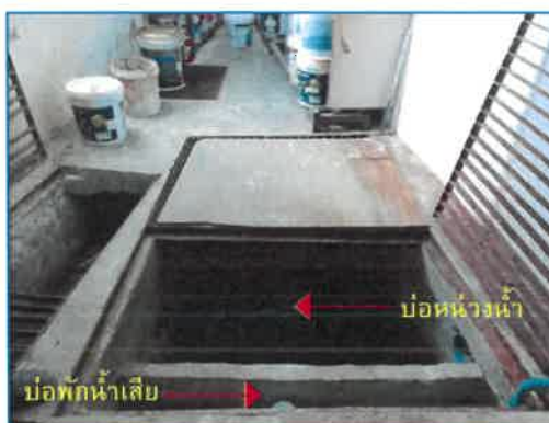
ภาพถ่ายที่ 2.2-13 บ่อหน้าและบ่อพักน้ำเสีย พร้อมตะแกรงดักมูลฝอย
