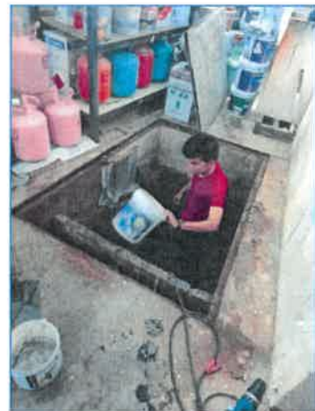
ภาพถ่ายที่ 2.2-14 การลอกตะกอนจากรางระบายน้ำและบ่อพักน้ำ
