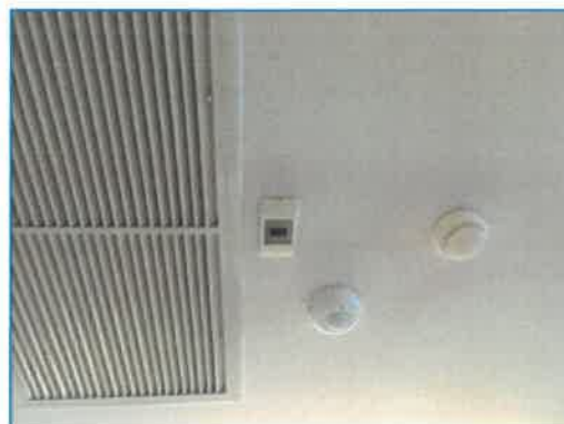
ภาพถ่ายที่ 2.2-24 อุปกรณ์ไฟฟ้าส่องสว่างในห้องน้ำส่วนกลางแบบมีเซ็นเซอร์ตรวจจับ
