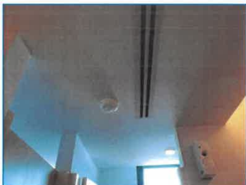
ภาพถ่ายที่ 2.2-24 อุปกรณ์ไฟฟ้าส่องสว่างในห้องน้ำส่วนกลางแบบมีเซ็นเซอร์ตรวจจับ
