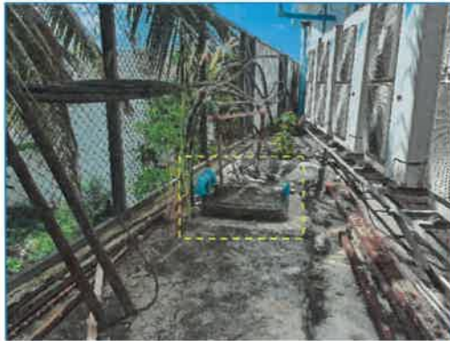
ภาพถ่ายที่ 2.2-16(2) ระบบท่อ vent พิวชีเพื่อระบาย ก๊าซมีเทน
